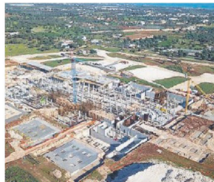
NUOVO OSPEDALE Foto aerea del cantiere
