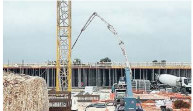
Il cantiere dell'ospedale in costruzione tra Fasano e Monopoli
