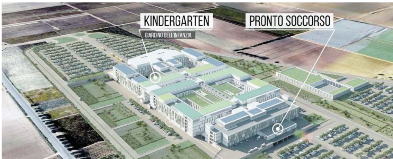
Qui sopra e in basso due rendering del progetto per il nuovo ospedale San Cataldo
